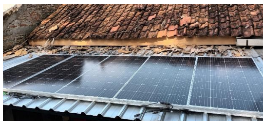
Gambar 9. Hasil pemasangan panel surya 780 x 152 cm
