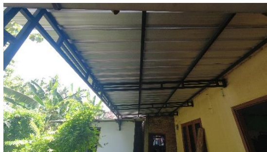
Gambar 4. Penyangga besi dan seng galvalum sebagai penopang panel surya
