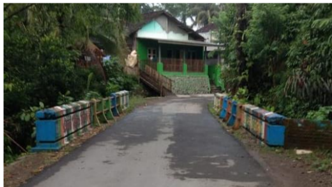
Gambar 13. Gambar Kondisi Jembatan Kali Longkrang Tonjong
