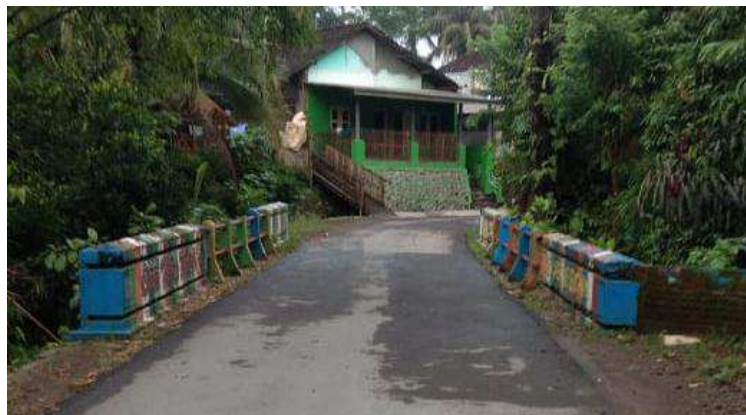
Gambar 13. Gambar Kondisi Jembatan Kali Longkrang Tonjong
